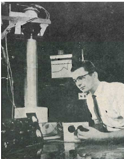
Giaever regola un dispositivo che sfrutta il « tunneling ». Sullo sfondo lo strumento registratore traccia la curva corrente-tensione. Si noti il tratto a pendenza negativa.
